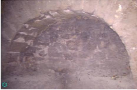
Abbildung 3: Mauerbogen im Übergangsniveau von Rechteck- auf Rundprofil (Standbild der Kamerabefahrung vom 20.10.2021).
